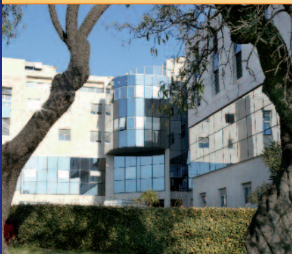
Centre Hospitalier de Béziers Site de Montimaran
