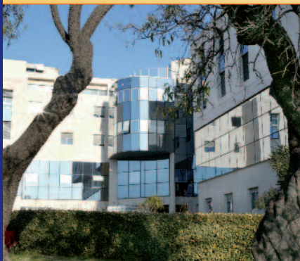
Centre Hospitalier de Béziers Site de Montimaran
