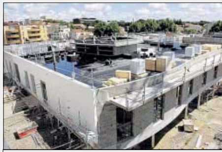
Les espaces de vie vont être réaménagés.
